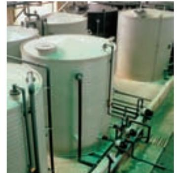
*Cuves en polypropylène = stockage de produits jusqu'à + 90 C°.*
